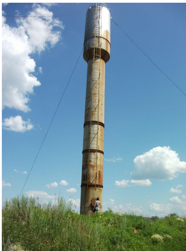
Башня Рожновского с. Лопатино
